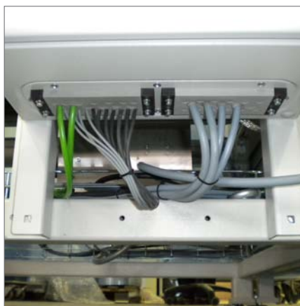
KEL-DPZ 24|x - Sivu 62 - 63 / FP/AE 330 - Sivu 149 Kaapeleiden sisäänvienti AE-koteloon. Käytössä valmiiksi aukotettu FP/AE - laippa ja KEL-DPZ - kalvo-läpiviennit.
