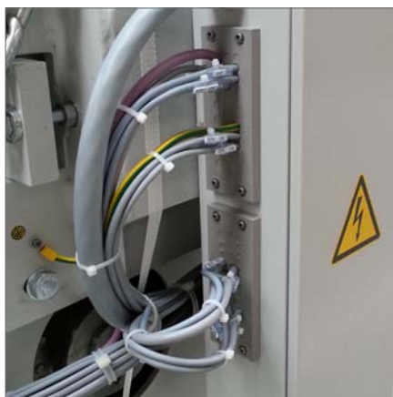
KEL-DPZ 24|x - Sivu 62 - 63 Useiden erikokoisten kaapeleiden läpivienti ohjauskaappiin tiivisyysluokassa IP65. Tyhjää tilaa myös mahdollisille lisäyksille.
