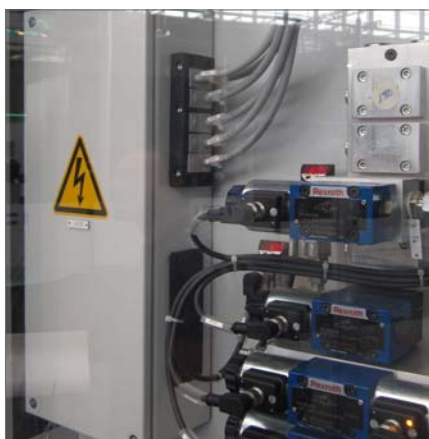
KEL 24|10 - Strana 16 / BPK 24 - Strana 154 Zavedení 6 kabelů jedním průchodkovým rámečkem. Další výřez je zaslepený plastovou deskou BPK 24.
