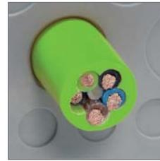
Vue détaillée de face, 1er joint d'étanchéité.
