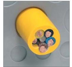
Vue détaillée de face, 1er joint d'étanchéité.
