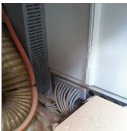
KEL-DP 24|50 - 详见 60 页 木工机械 在很小的空间里引入大量的无接头电缆。
