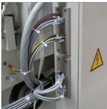
KEL-DPZ 24|x - 详见 52-53 页 特殊机器 引入大量不同尺寸的电缆到控制柜中，防护等级达到IP65。
